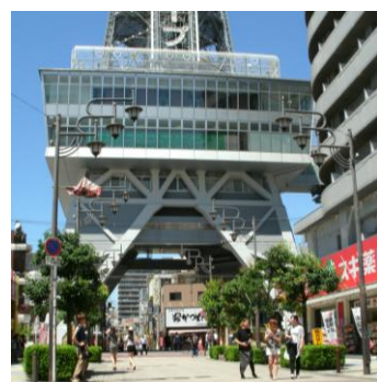
写真10. 竣工後風景(昼景)
