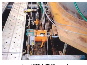
ノード部水平ジャッキ
