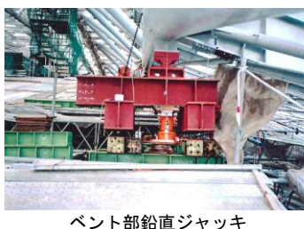
ペント部鉛直ジャッキ
