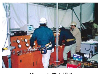
ジャッキ集中操作
