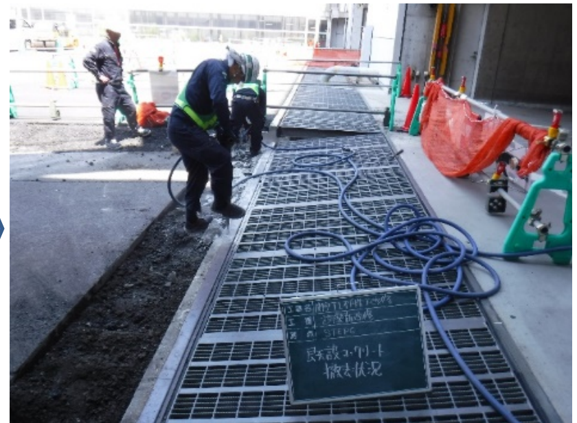
外構工事着手
