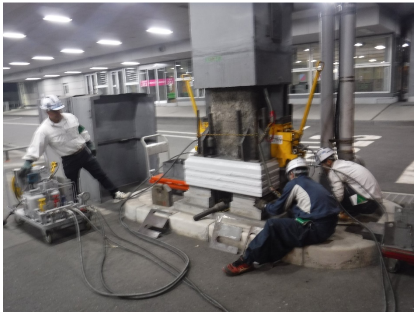
EXP.J付近一帯の先行ジャッキアップ状況
