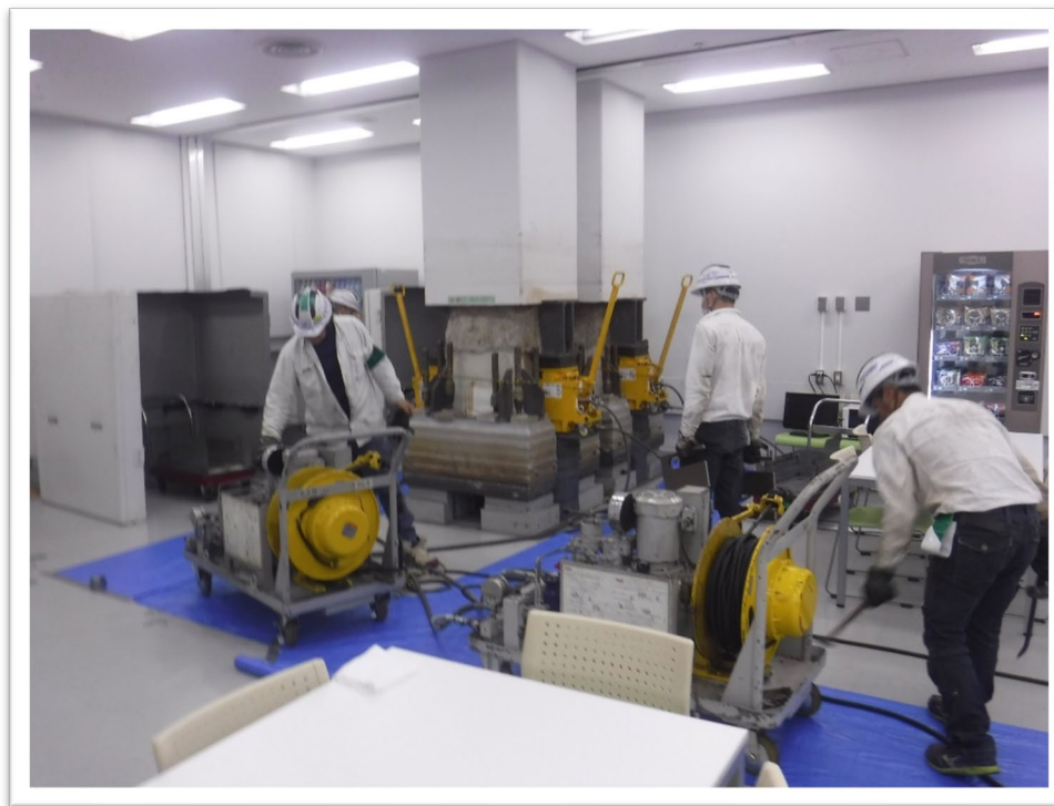
テナント内部作業状況
