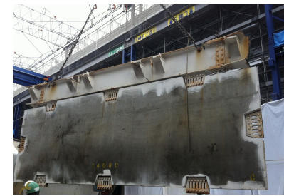
写真11 梁壁一体吊り
