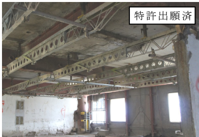
写真9 ペコビームによる支保工
