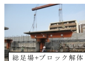
写真1 従来の解体工法
