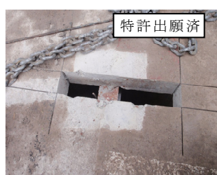
写真13 スラブ二重切断
