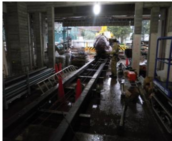
レール設置状況
