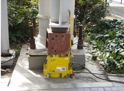
写真-6 中柱ジャッキ設置
