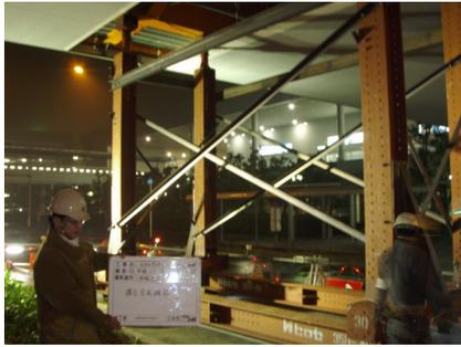
写真-3 架設柱設置状況
