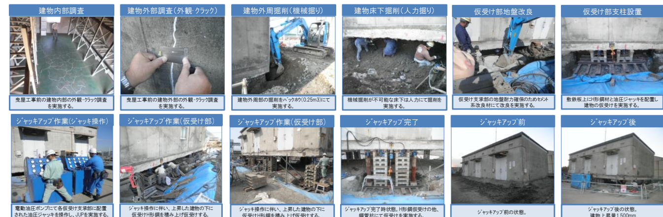
ジャッキアップ工事
