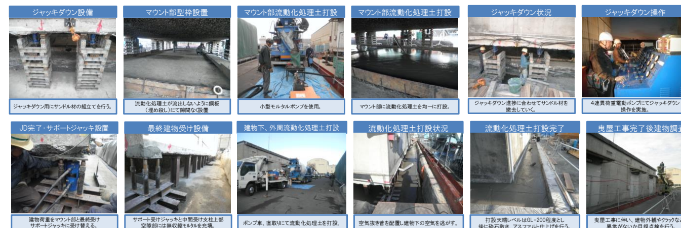
ジャッキダウン・定着工事
