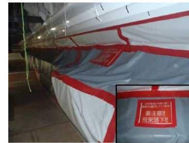
トラベリングステージ養生状況
