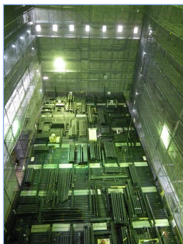
すのこ鉄骨地組状況 （タワー棟1階）
