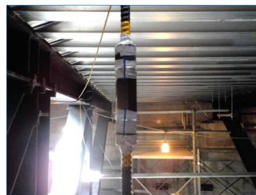
PC鋼棒ジョイント状況
