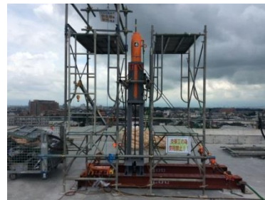
油圧ジャッキ設置状況
