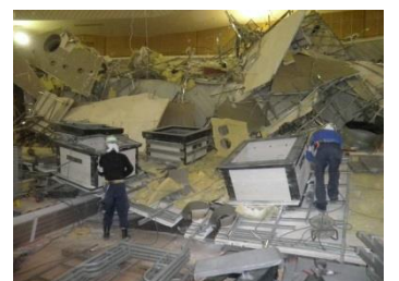
天井材解体作業
