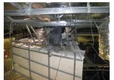
天井ボード切断
