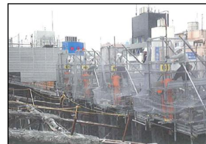
吊り下げ支承部
