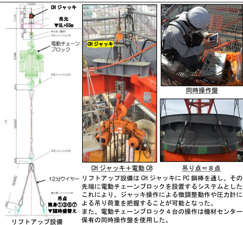
リフトアップ設備
