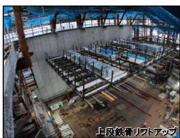
上段鉄骨リフトアップ
