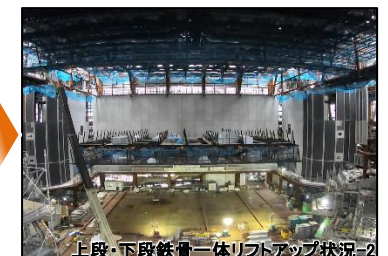
上段・下段鉄骨一体リフトアップ状況-2
