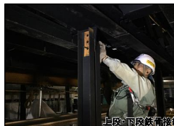
上段・下段鉄骨接続
