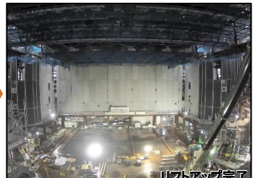
リフトアップ完了
