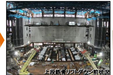
上段鉄骨リフトダウン前状況
