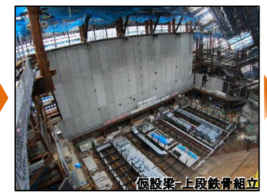
仮設梁・上段鉄骨組立
