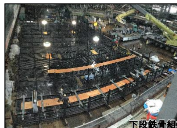
下段鉄骨組立
