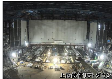
上段鉄骨リフトダウン
