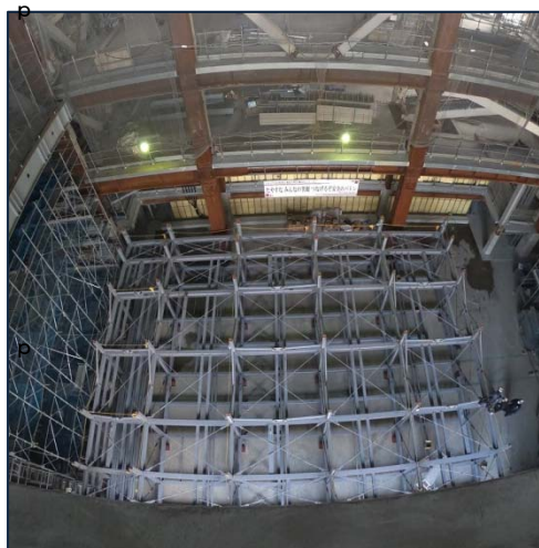
すのこ鉄骨地組み状況 (7 階)
