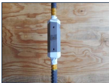
PC 鋼棒ジョイント状況
