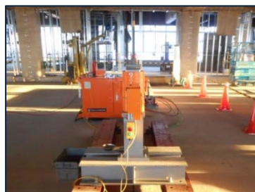
油圧ジャッキ設置状況
