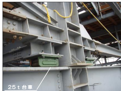
写真 7 25 t 台車設置完了状況
