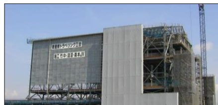
写真4 組立時屋根仕上げ兼外壁仕上げ用足場
