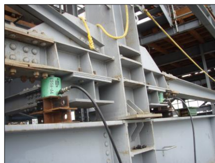
写真 6 25 t 台車設置状況
