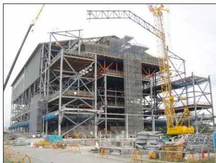
写真 10 屋根トラス鉄骨解体
