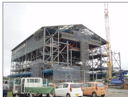
写真 12 トラベリング完了
