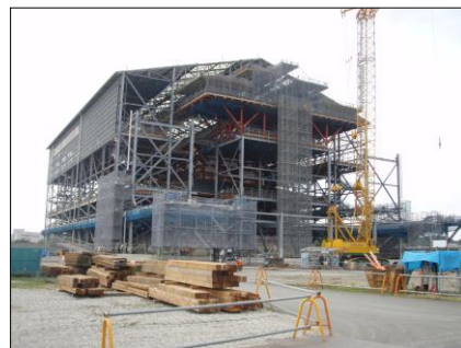
写真 11 2・3 節鉄骨一部解体
