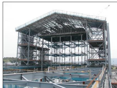
写真3 組立時ベント構台
