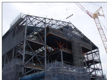
写真 9 屋根折板解体
