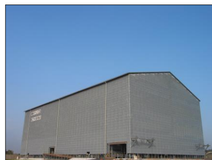
写真2 解体前素屋根概観
