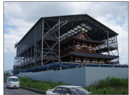
写真 13 第 2 回目トラベリング完了状況
