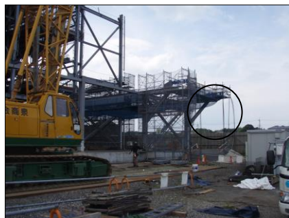
写真 8 ジャッキ設置状況
