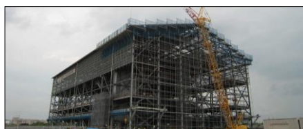
写真5 解体時屋根解体足場
