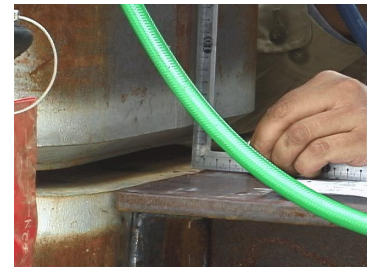
残移動量の計測状況
