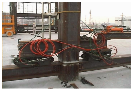
スライドジャッキ設置状況
