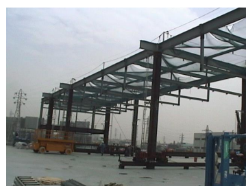
第1回目トラベリング前状況
