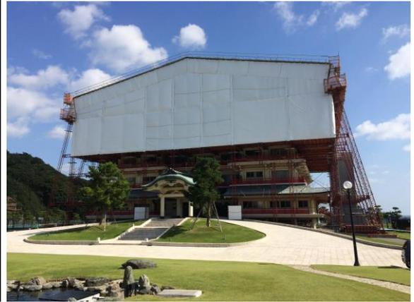
写真 3\_クラウン形状の素屋根設置状況
