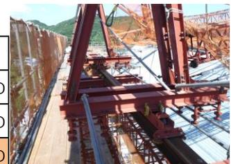
写真4\_簡易なトラベリング機構
