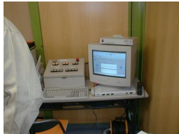
ジャッキ操作状況
