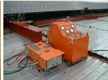
速度制御用補助ポンプ
