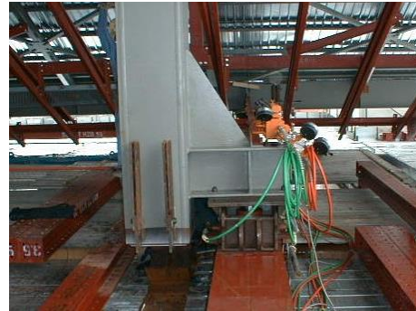
前方支承部側
