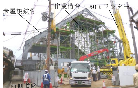
写真-6 素屋根(移動体)建方状況
