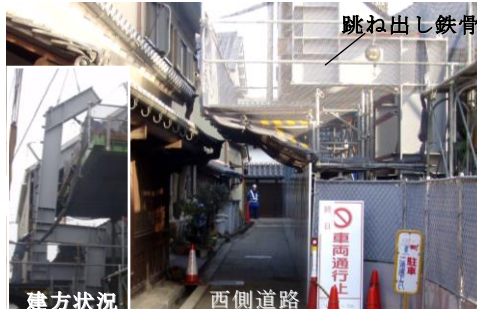
写真-7 西側前面道路の状況
