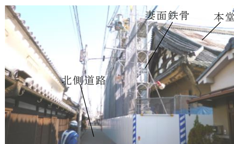
写真-5 先行建方鉄骨(妻面)
