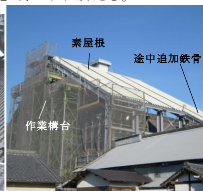
写真-10 素屋根外観
