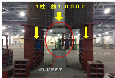
図 17. 柱切断状況
