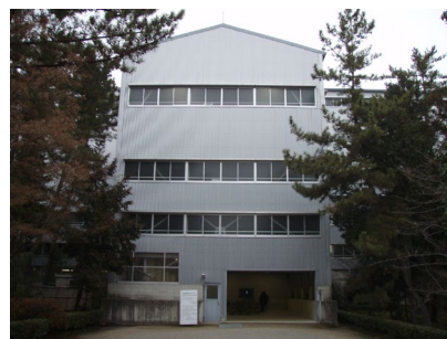
写真-1 素屋根外観（東面）
