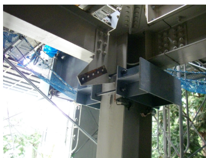
写真-10 ジャッキ架台固定部詳細
