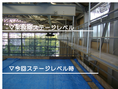
写真-7 仮設ステージレベル
