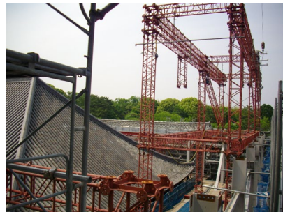
写真-16 素屋根解体後のパーフェクトビーム解体状況
