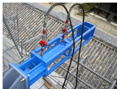
写真-4 50 t ジャッキ取付状況
