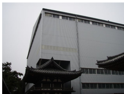
写真-2 素屋根外観（北東面 手前が故楼）
