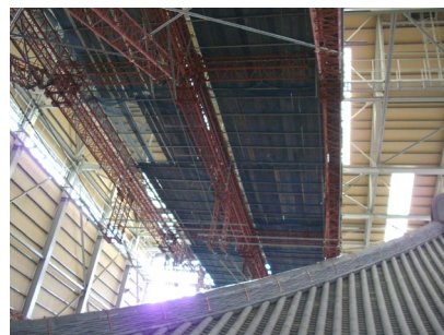
写真-12 パーフェクトビーム架設状況
