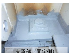
支承部（固定側）
