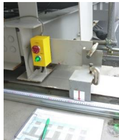
支承部、作業確認BOX
