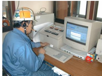
ジャッキ操作状況
