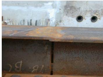
軌条レールとトラス位置の確認
