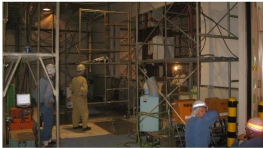
本工事「本州製罐結城工場 基礎沈下に伴う補修工事」は基礎沈下に伴い沈下量が大きく確認された既設鉄骨柱に対して、沈下レベルの修正および今後沈下が予測される数値分をジャッキアップにて上昇させる工事である。
